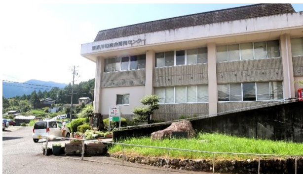
避難所のひとつ 熊野川町総合開発センター
